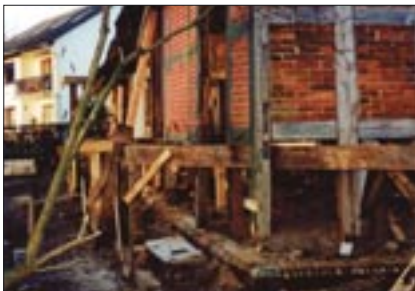
2002: Fachwerksanierung bei der alten Schule durch den jetzigen Eigentümer Michael Pilbauer, ehemaliges Klassenzimmer.
