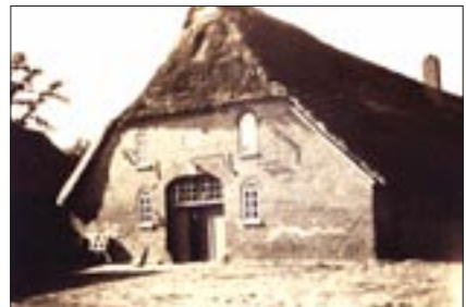
Der Giebel auf der Dieleseite wurde bereits Ende des 19. Jahrhunderts massiv in Stein gemauert; das Strohdach 1955 durch Pfanneneindeckung ersetzt, das Fachwerk an den Längsseiten um 1957 entfernt, am Giebel der Wohnseite erst nach 1970.
